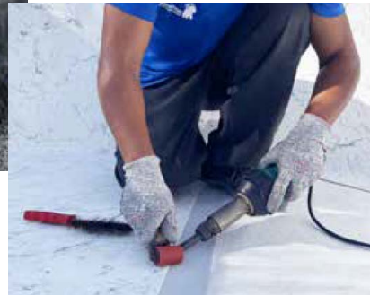
Soudure bord à bord Butt welding
